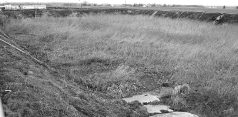
Jedna takiej wielkości laguna pozwala na 10 lat składowania na niej osadów pościekowych. Tej samej wielkości tradycyjny obiekt wystarcza najwyżej na dwa lata.
